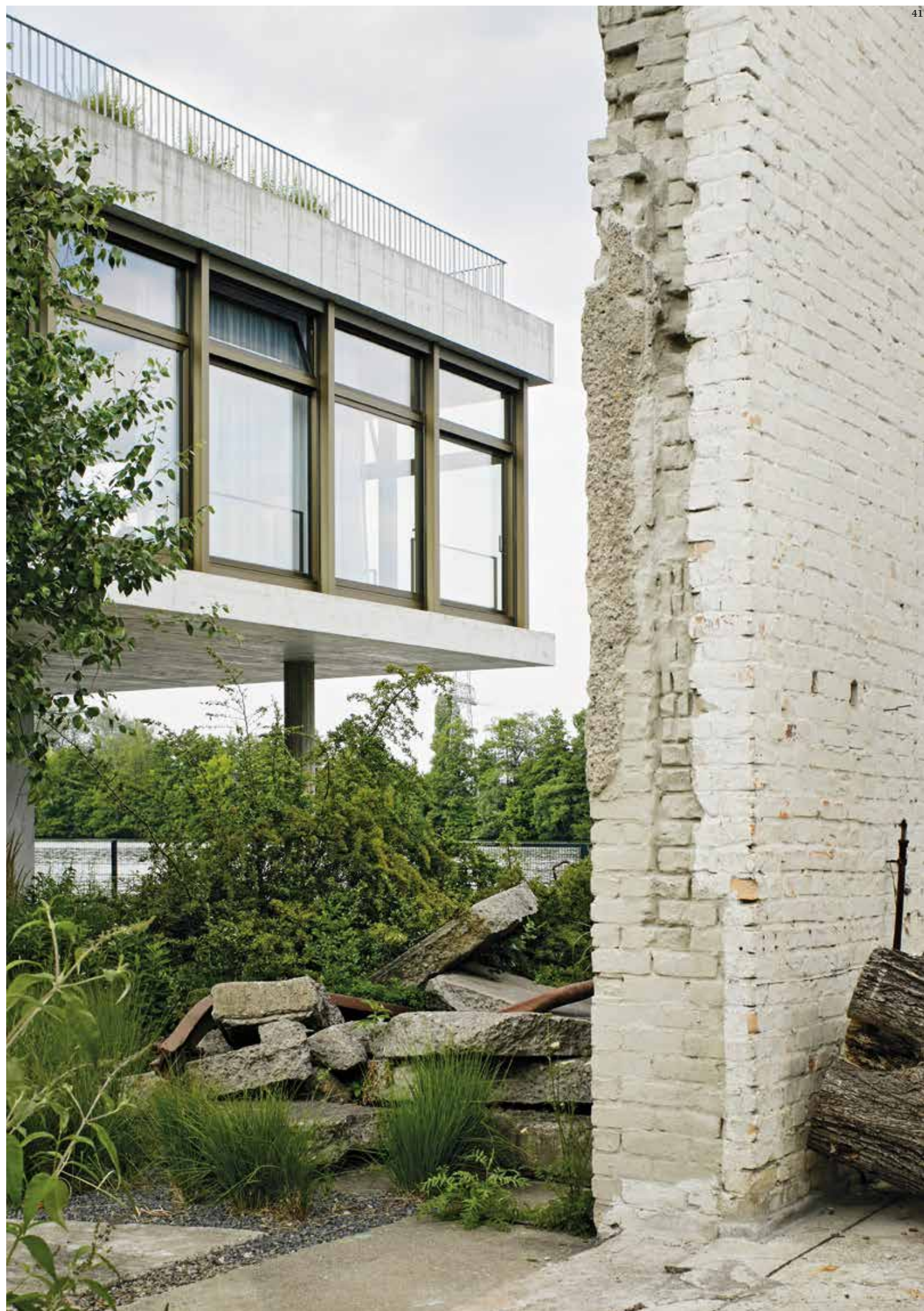
42 la casa, sopraelevata su pilotis, consente di mantenere la vista diretta della Spree dall'interno del lotto. Il calcestruzzo leggero del nucleo centrale, dei pilastri e dei solai è in armonia con l'ambiente industriale circostante. Il solaio orizzontale sospeso riverbera i riflessi dell'acqua the house, raised on pilotis, permits a direct view of the Spree from the inner part of the lot. The light concrete of the central core, the pillars and the slabs is in tune with the surrounding industrial setting. The suspended horizontal slab is enlivened by reflections from the water
